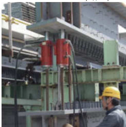
Домкрат гидравлический с полым штоком 1000кН
