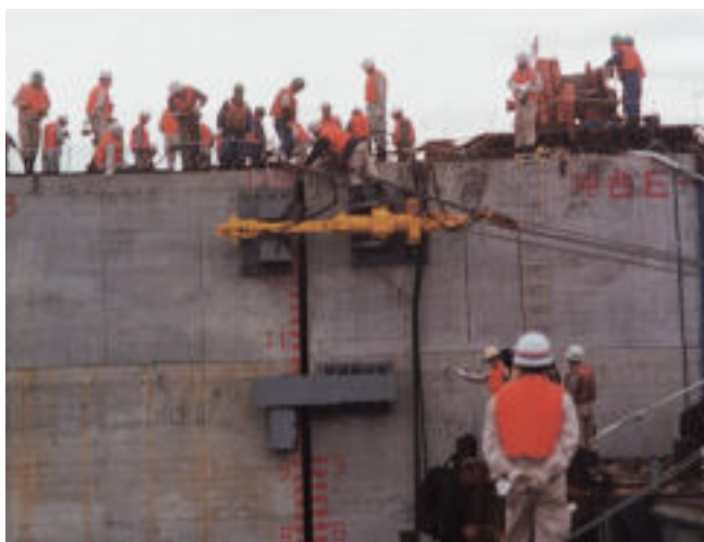
При соединении кессонов аккуратно подведите их друг к другу при помощи лебедки, а затем используйте гидравлический домкрат для надежного крепления.
