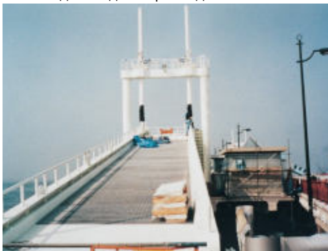
Длина штока гидравлического цилиндра 8720мм, диаметр 250мм.
