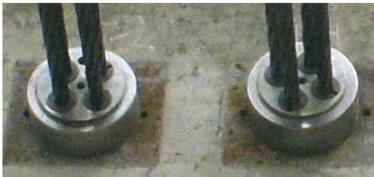
Установка обоймы анкера
