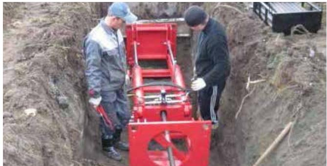
ком. Затем в приемном котловане надевается специальный нож-расширител, который, при обратном протягивании, продольно разрезает данный участок трубы с расширением или без него. При этом остатки старой трубы вдавливаются в грунт, а скважина расширяется до диаметра новой трубы. За расширителем устанавливается специальный захват, с помощью которого протягивается новая труба.
