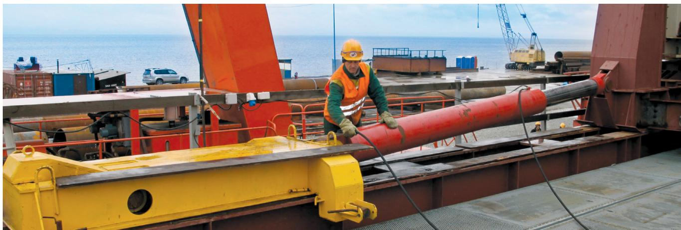
■ Толкающий комплекс, модель ТМК400Г2500 применен для продольной надвижки мостовых конструкций по металлическим балкам с дискретным упором за поперечные балки (накаточный путь) при строительстве низководного мостового перехода через Амурский залив к полуострову Де-Фриз, г. Владивосток.
